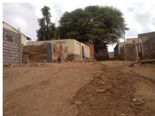
Arta - Habitat consolidé - Photos du consultant
