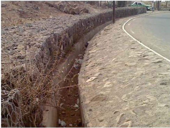
Fossé maçonné sur la route d’accès à la ville
