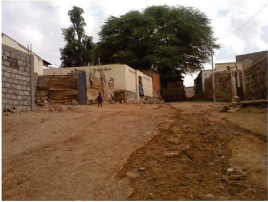
Constructions sur l’emprise de la voie
